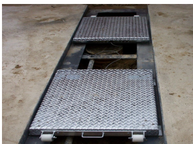
Stor åbning til at bortlede overflade vand
